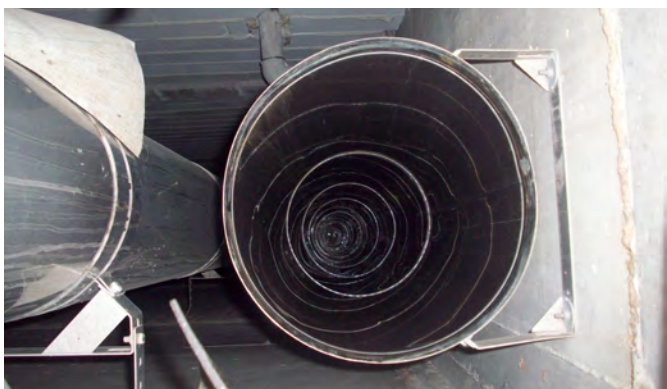
IN KIJK IN EEN KANAAL (ROND 355 RVS) 35 METER DIEP
