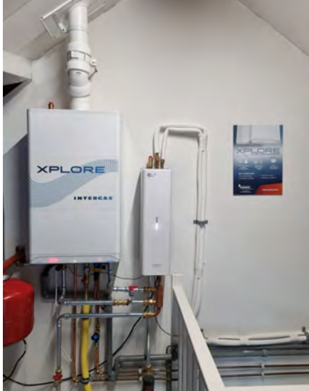
De hybride warmtepomp met waterstofketel (Intergas).
