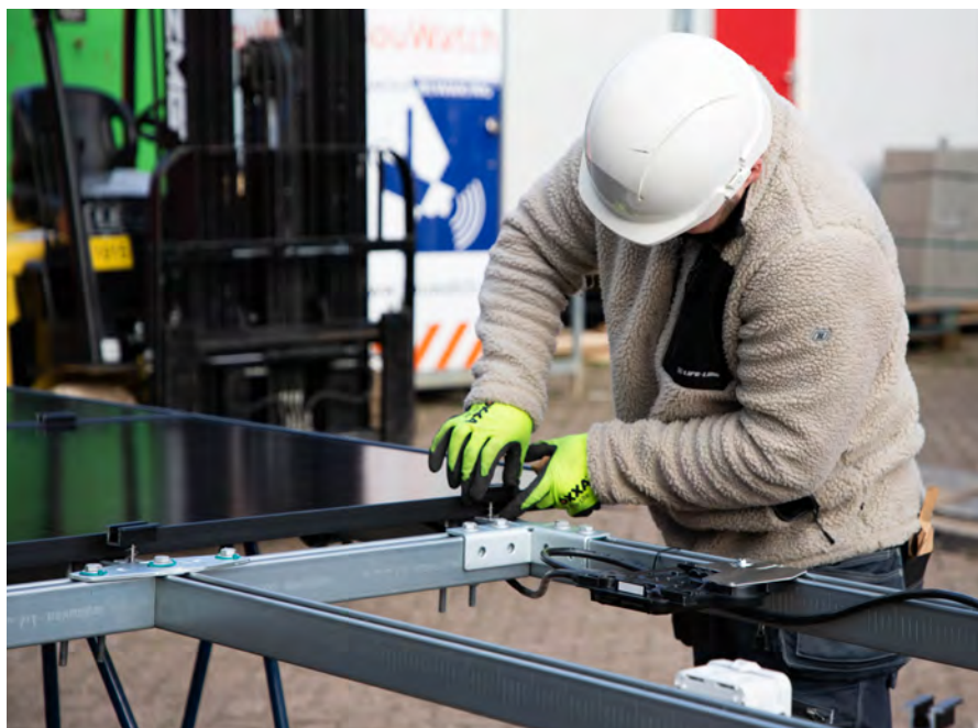
Tijdens de renovatie is er op het dak een Solarmodule geplaatst en heeft de flat een hybride warmtepomp beneden in het gebouw gekregen.
