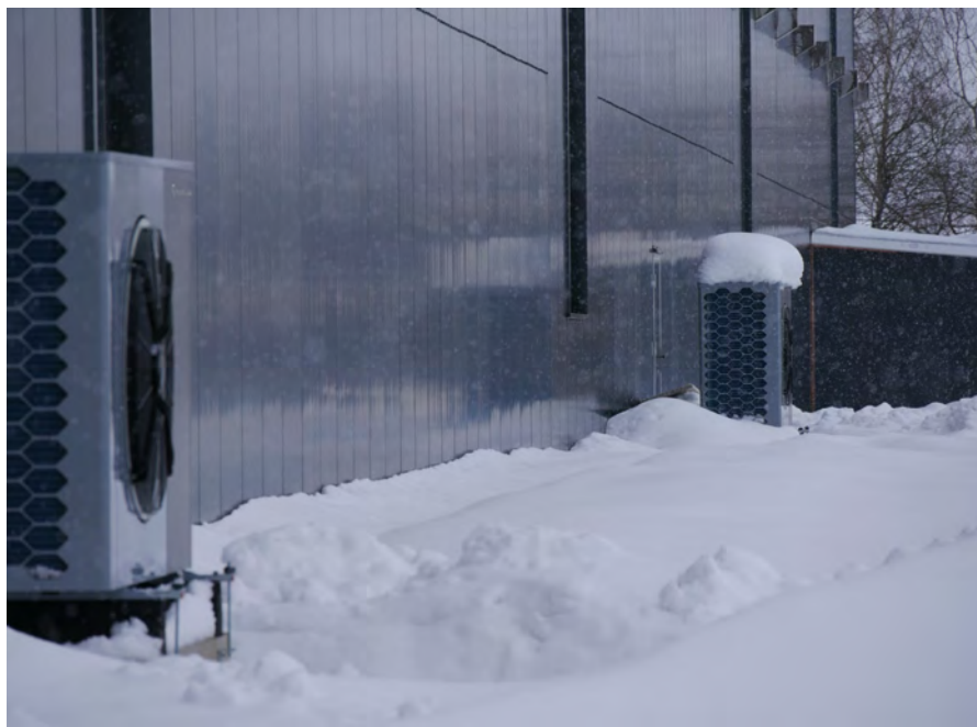
Het buitendeel van de Kita Air Cold onttrekt warmte-energie uit de omgevingslucht, zelfs bij zeer lage temperaturen tot -30 °C.
