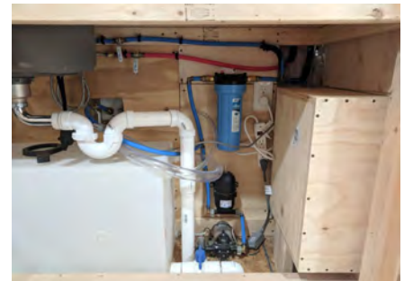
Sanitairwerk in Tiny House
