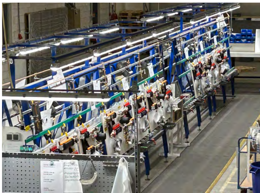
Prefabben oftewel prefabriceren is het proces waarbij installatieonderdelen of samengebouwde installatiemodules van een gebouw of installatie vooraf in een fabriek of werkplaats worden geproduceerd en vervolgens op de bouwplaats worden gemonteerd. (Foto Breman)
