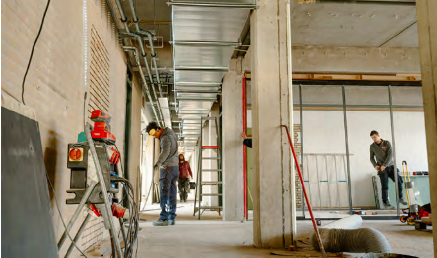
Het oorspronkelijke kantoor was erg 'hokkerig' en is daarom opengebroken tijdens de renovatie.
